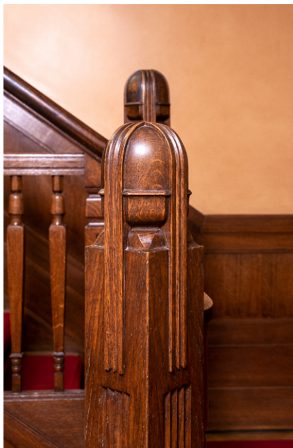
Poteau de départ de l'escalier d'honneur.
