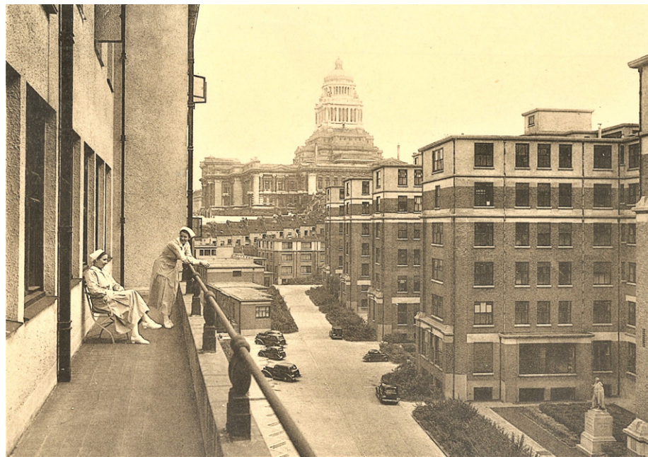
Le nouvel Hôpital Saint-Pierre, fin des années 1930. Architecte Jean-Baptiste Dewin. Collection de l'auteur.
