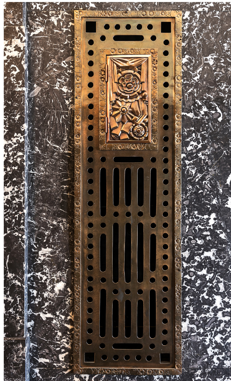
Grille du cache-radiateur du hall d'entrée.
